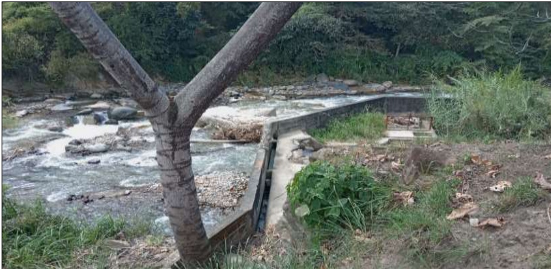
FIGURA N°03: CAPTACIÓN DE AGUA CANAL CHILILIQUE MONTEGRANDE VULNERABLE FRENTE A UNA MÁXIMA AVENIDA DE LA QUEBRADA JAÉN
